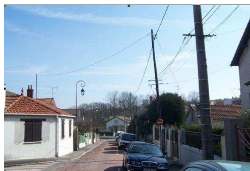
Rue du Progrès avant travaux
