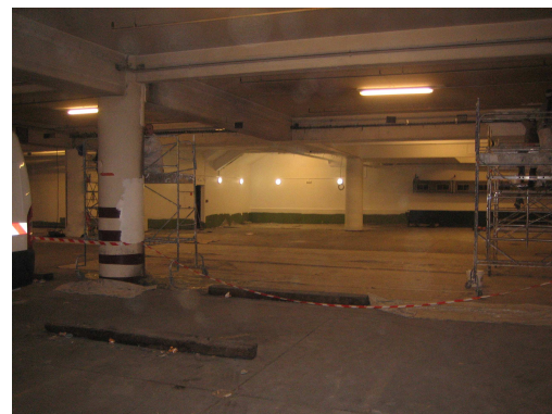
Parc de stationnement en travaux
