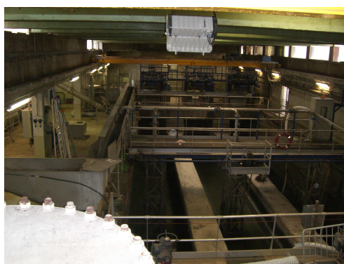
Salle des bassins de dessablement de l'usine d'Ivry
