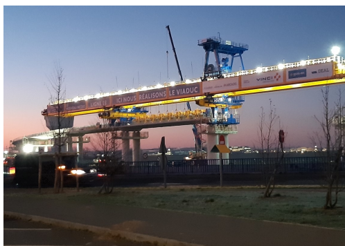
Construction de la ligne 18
